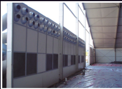
Instalación de aire acondicionado
