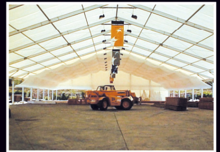
Instalación doble techo
