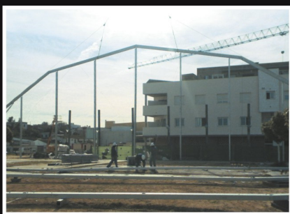
Elevación de estructura
