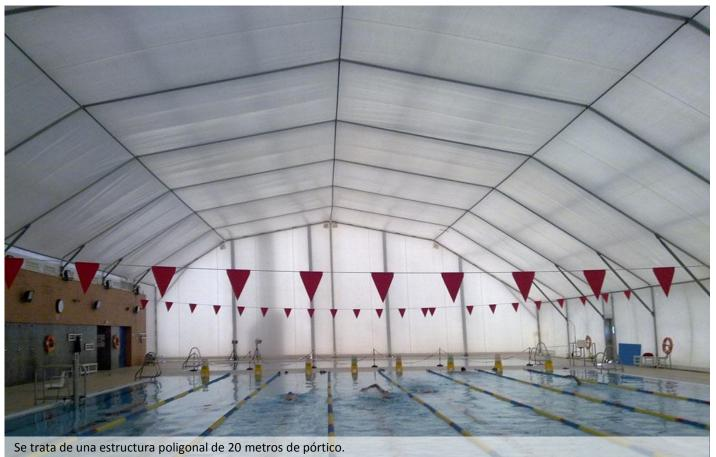
Se trata de una estructura poligonal de 20 metros de pórtico.
